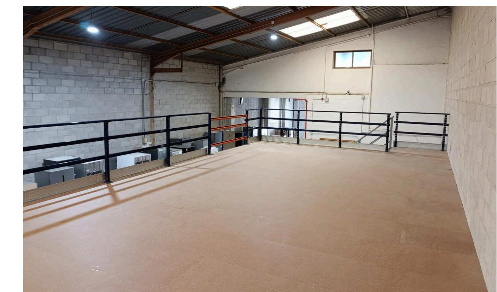
Están constituidas por una estructura metálica sobre la que se dispone un suelo, de madera o metálico con diferentes acabados, que proporciona una superficie extra de almacenamiento.
